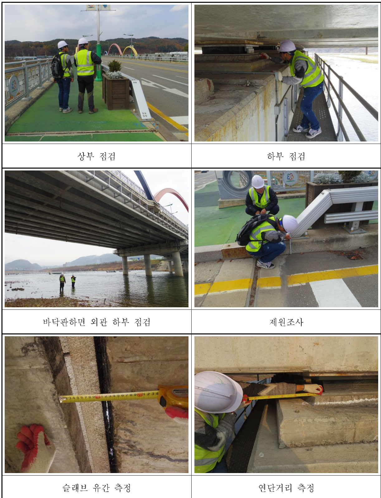
【그림 3.2】 외관조사 전경
