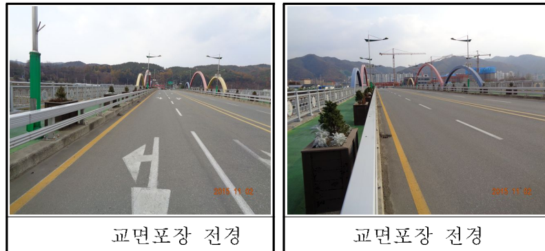
【그림 3.3】 교면포장 현황
